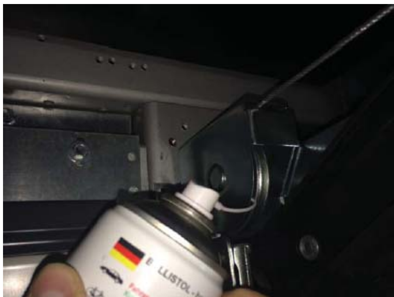
6. Umlenkrollen schmieren
